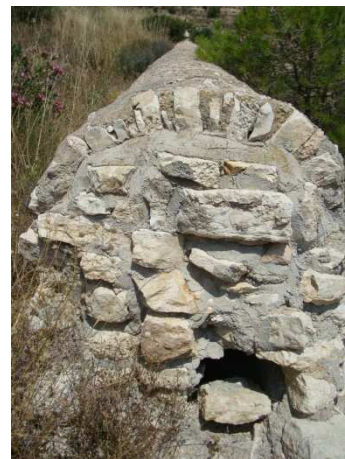
5. La bóveda de la acequia tapiada.
