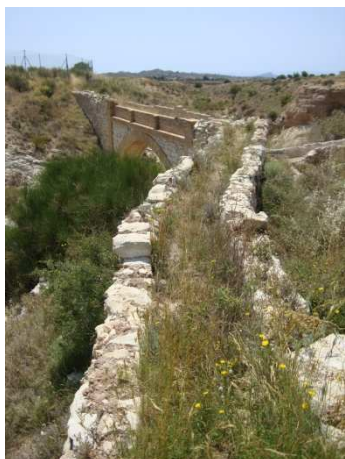
6. Acequia descubierta hasta el acueducto.
