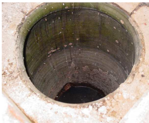
7. Vasija vidriada enterrada para decantación del agua del aceite
