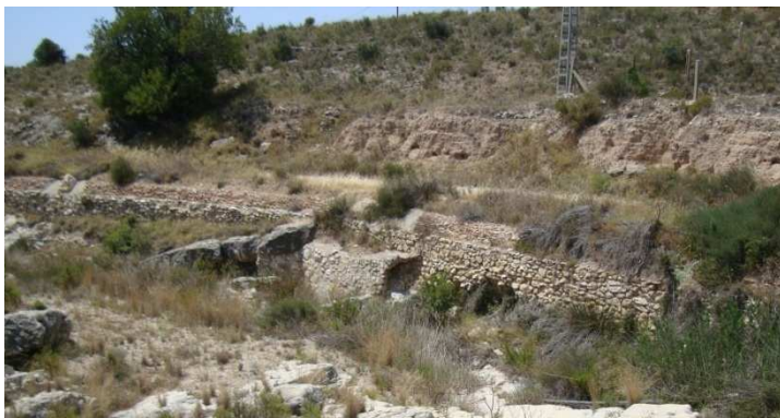
2. Acequia cubierta por una bóveda.
