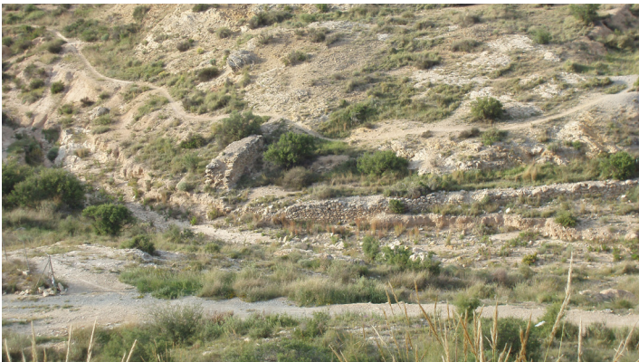
Mur de contenció
