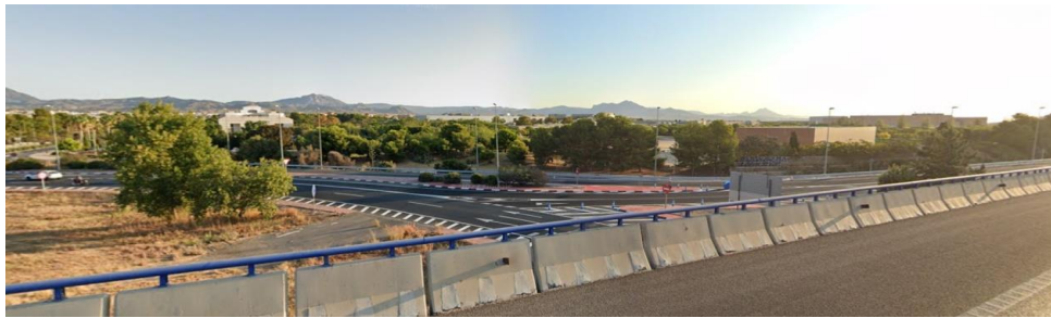
B5. Vista hacia el ámbito desde la A-70 sobre la rotonda de la Universidad.
